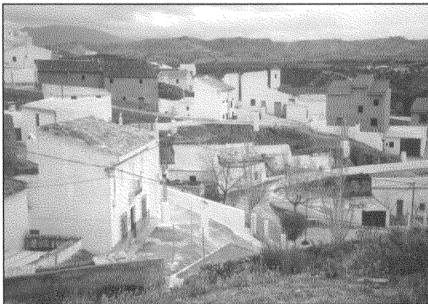
rehabilitaciones en el barrio de casas-cueva
